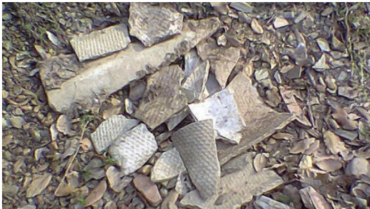
Fragments de fibrociment d'amiant trencat.
